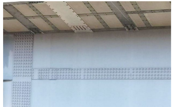
図-1 高力ボルト摩擦接合継手
