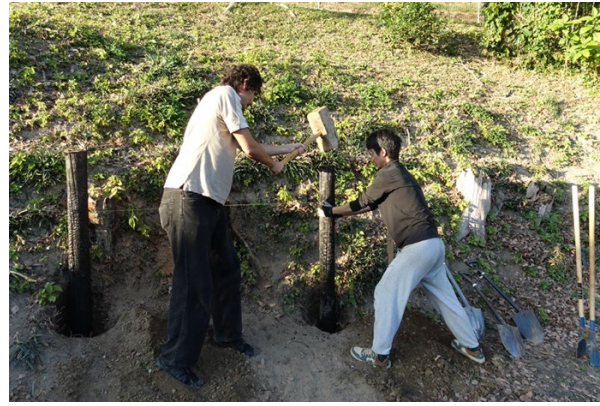
図 10 焼杉杭打込みの施工写真
