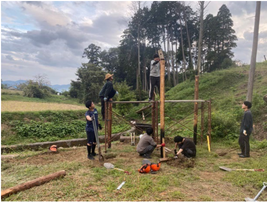
図 9 掘立て杭打込みの施工写真
