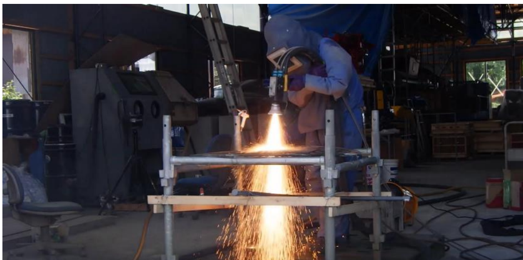
金属溶射の施工の様子
