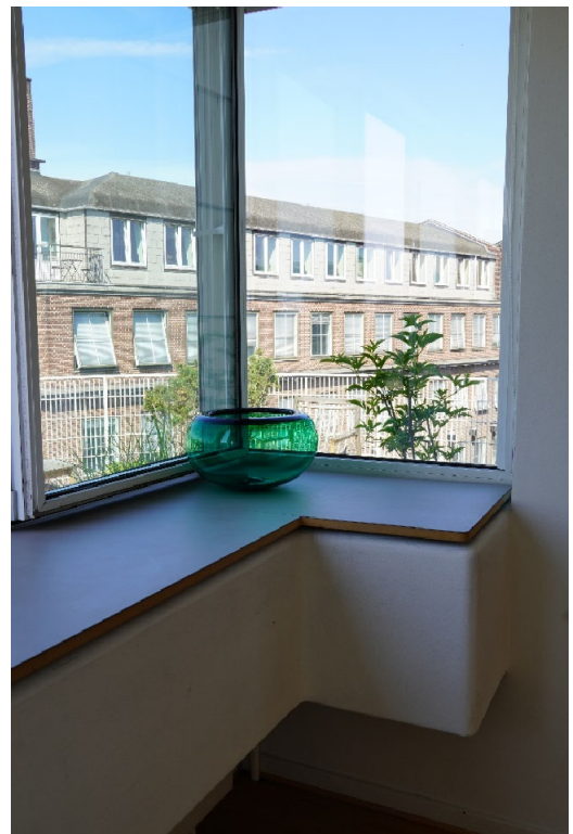
図 2-7 壁一体プランターとして設計された Stelling Hus の窓辺
