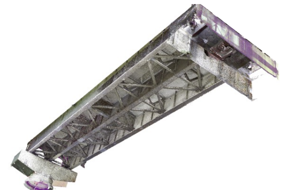
取得した鋼橋の点群データ
